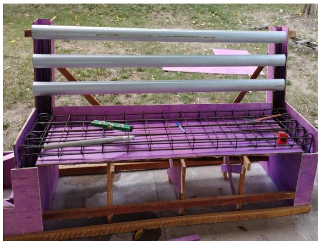
Imagem 3: Colocação das ferragens no interior da forma.
