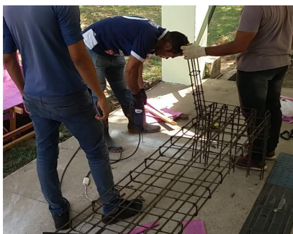
Imagem 2: Cortes e amarração das ferragens para a construção do banco de concreto armado.
