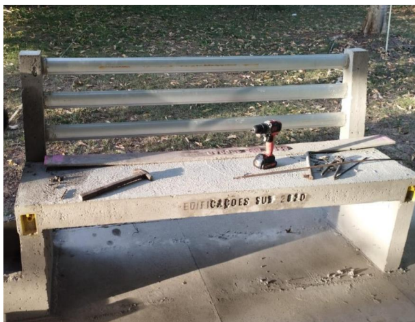
Imagem 7: Acompanhamento do processo de cura do concreto.
