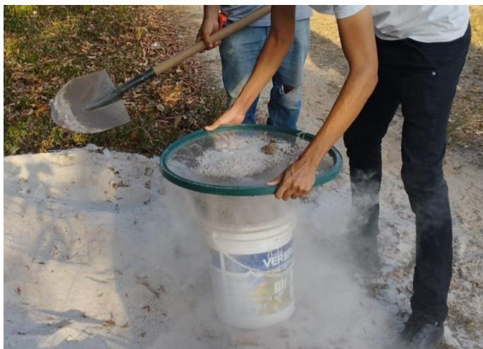
Imagem 4: Coleta e peneiramento do agregado miúdo (areia) para a fabricação do concreto.
