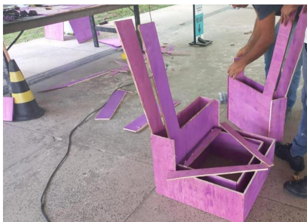
Imagem 1: Preparação da forma, em madeira, para a construção do banco de concreto armado.
