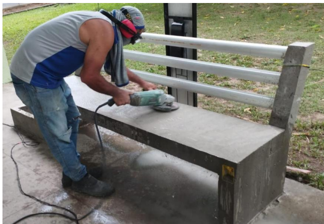
Imagem 8: Processo de lixamento para acabamento do banco de concreto armado.
