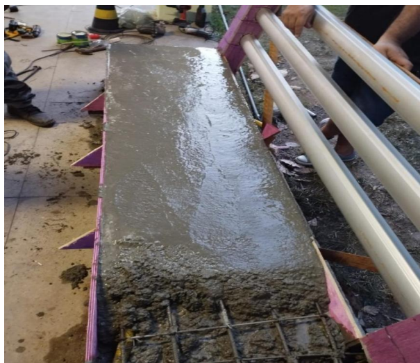
Imagem 6: Enchimento do concreto nas formas para fabricação do banco.
