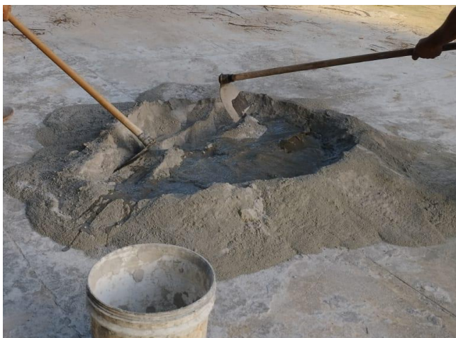
Imagem 5: Mistura dos materiais para fabricação do concreto.
